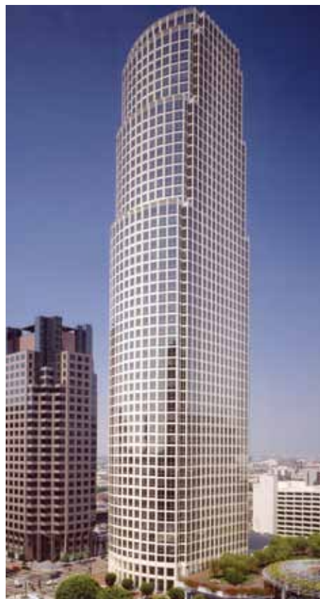
777 Tower, Los Angeles, CA.
