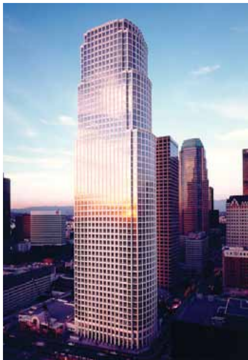
777 Tower, Los Angeles, CA.
