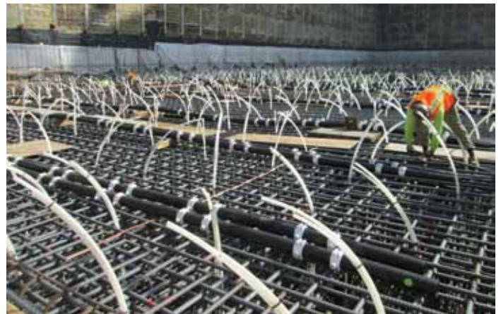
Cooling pipe for mat pour.
