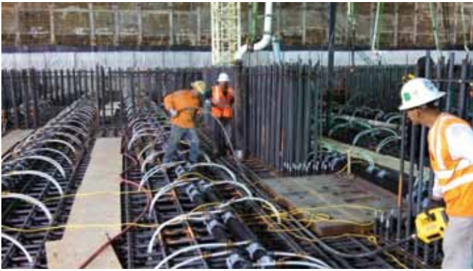
Vibrating the mat pour.
