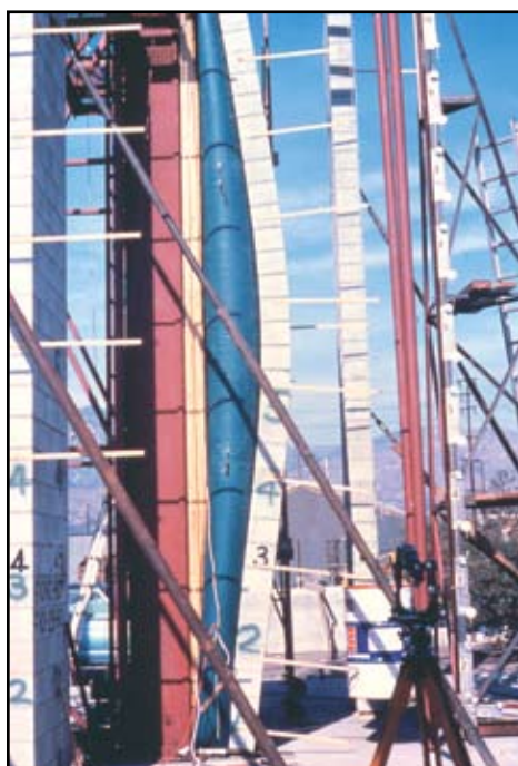
CMU Test Panel (1981).
