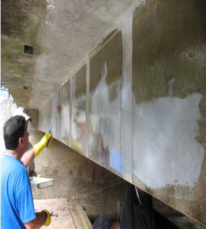
1 - Apply the primer component
